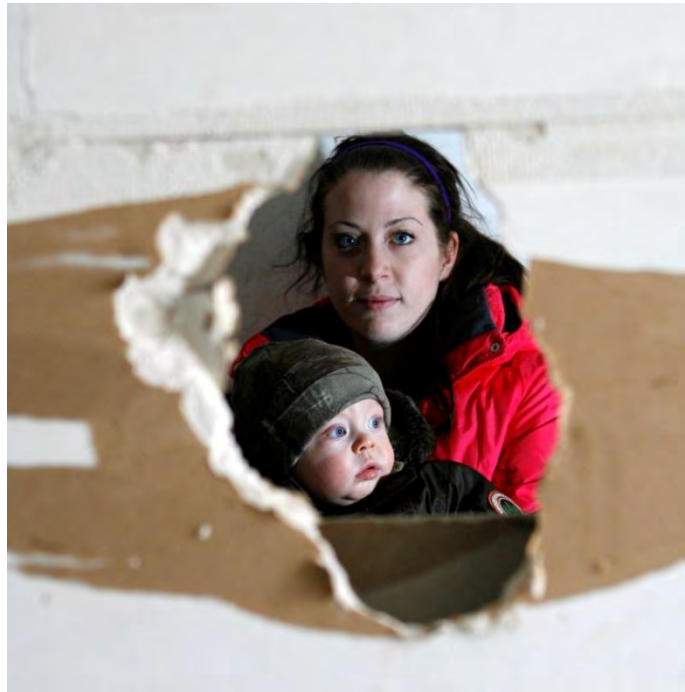
Photo : Matthew Sherwood, Telegraph-Journal. Une mère et son nourrisson aperçus à travers un des nombreux trous dans les murs de l'immeuble d'habitation de deux étages qu'ils habitent dans la Première nation de Woodstock.
